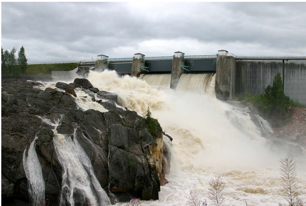
Krokströmmens kraftverk Foto: Härjedalens kommun/Henry Jonasson
