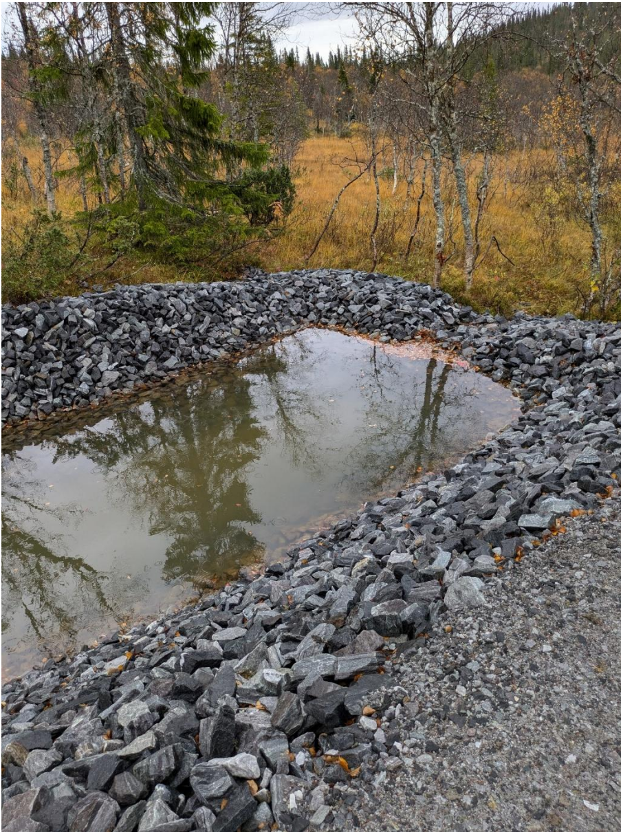
Figur 16. Exempel på sedimentfälla som också kan utgöra en permanent fördröjningsanläggning.
