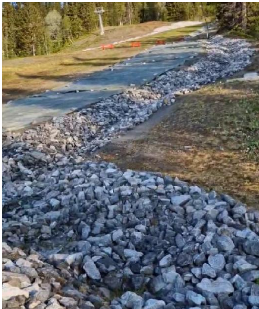
Figur 15 - Nylagt krossdike i annat skidsystem. Figur från referensprojekt utfört av Tyréns (2025).
