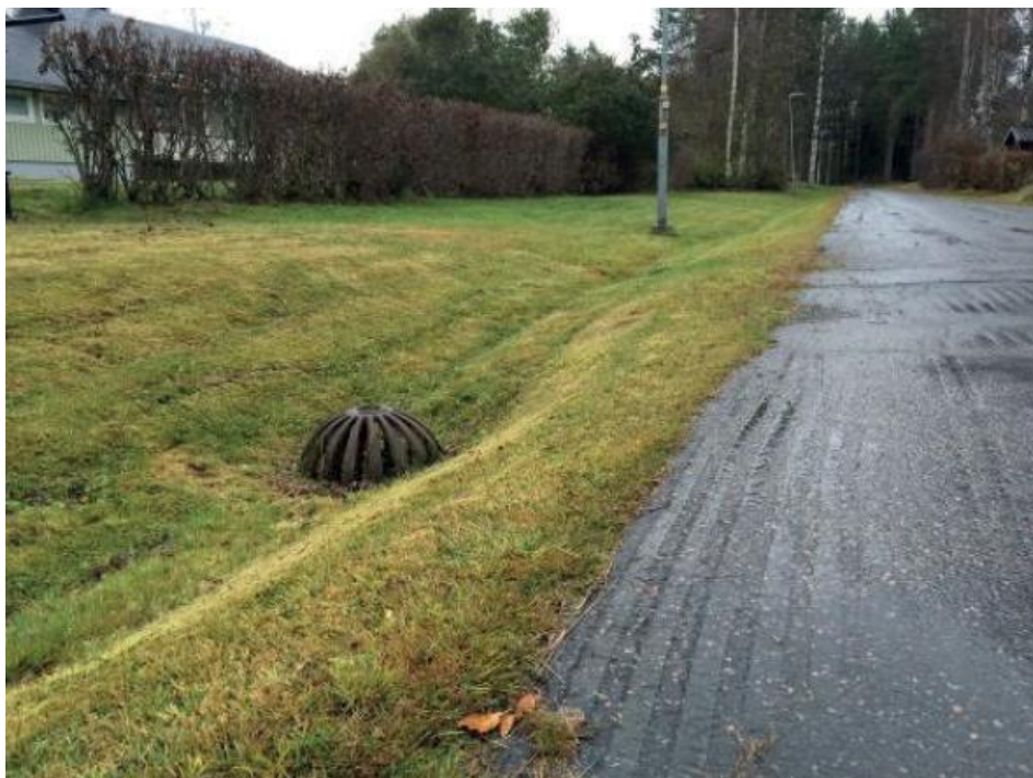
Figur 14 - Exempel på svackdikesutformning. (Svenskt Vatten Utveckling, 2016)
