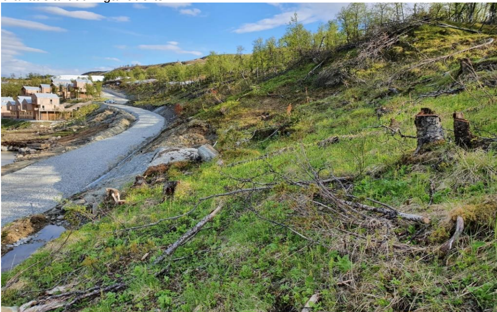
Figur 4. Brant slänt mot öst. Bebyggelse har utförts i kring släntens fot. (foto från 2022-06-13)
