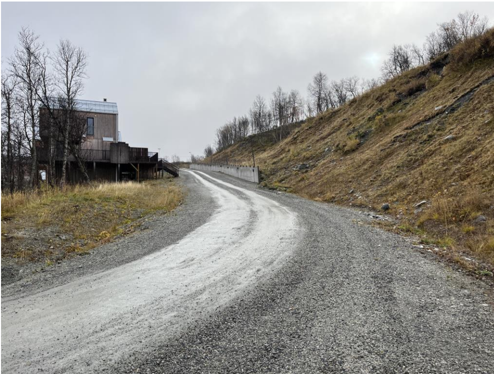
Figur 4a. Stödmur vid slänt (foto 2025-10-12)
