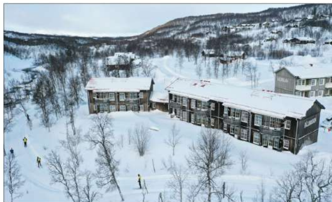
Fjällbruden. Uppförd av Delins Fjäll & Fastighets AB. Arkitekt okänd. 2009.
